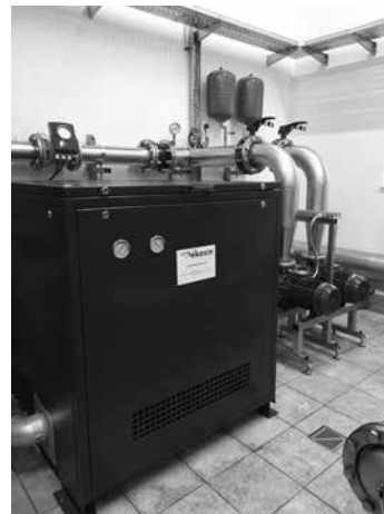
Dmuchała płuczająca oraz zestaw pomp płuczających filtry
