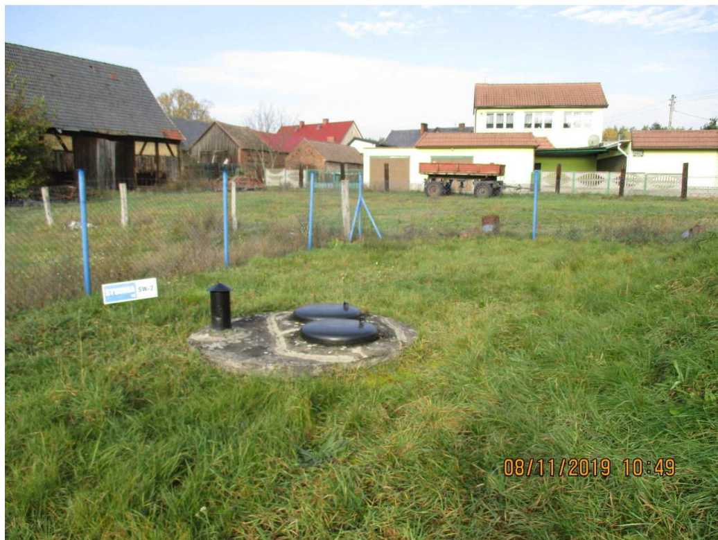
Zdjęcie 2 Istniejące ujęcie wody – studnia SW2
