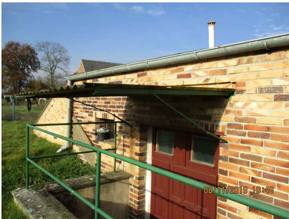
Zdjęcie 8 Wejście do budynku Ujęcia Wody
