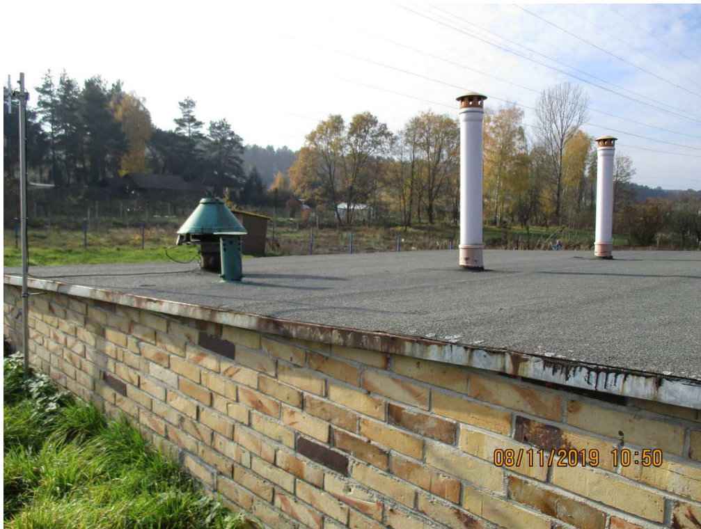
Zdjęcie 5 Dach budynku Ujęcia Wody
