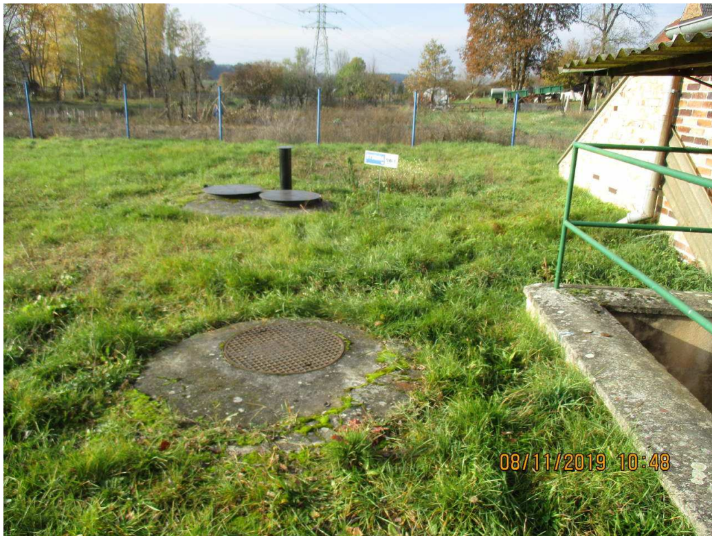
Zdjęcie 1 Istniejące ujęcie wody – studnia SW1
