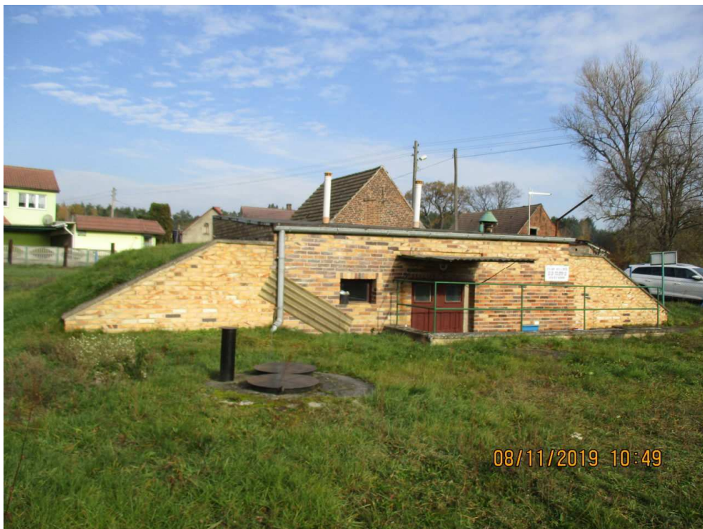
Zdjęcie 4 Budynek Ujęcia Wody
