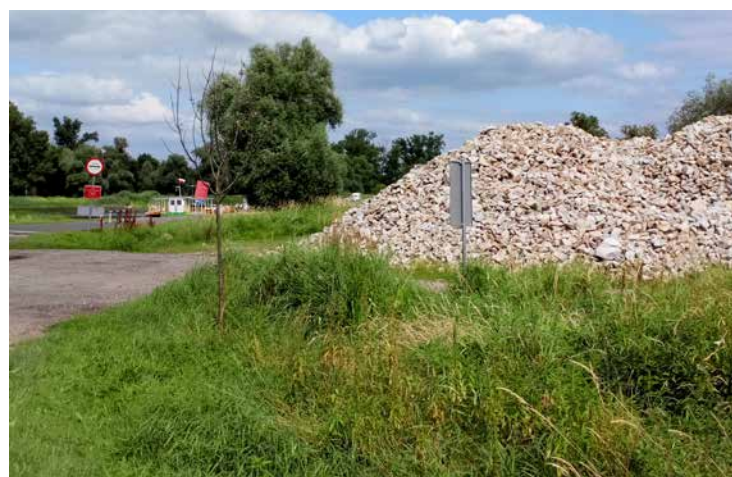
Hałda kamieni obok promu w Brodach powoli maleje - czyli prace gdzieś trwają
