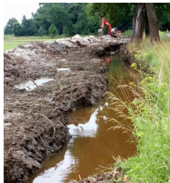
Melioracja dawno nie była tak potrzebna - prace obok Dobrzęcina
